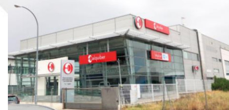
Oficinas Centrales (Fuenlabrada – Madrid)
